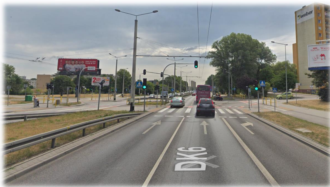
Rys. 2. Skrzyżowanie ulic Morska - Zbożowa w Gdyni, widok z wlotu zachodniego (ul. Morska).
